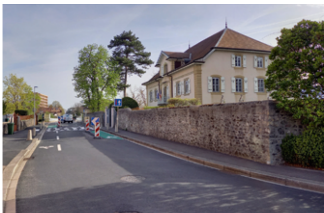
Fin des travaux de la rue des Vignes
